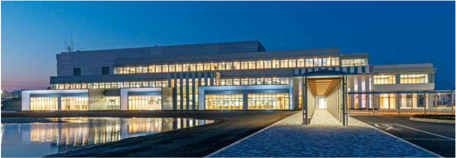
左上／1階多目的ホール ピロティとの一体利用に配慮 右上／2階執務室 中央に執務専用の内階段を計画し、上下階のスムーズな連携に配慮* 下／正面夜景
