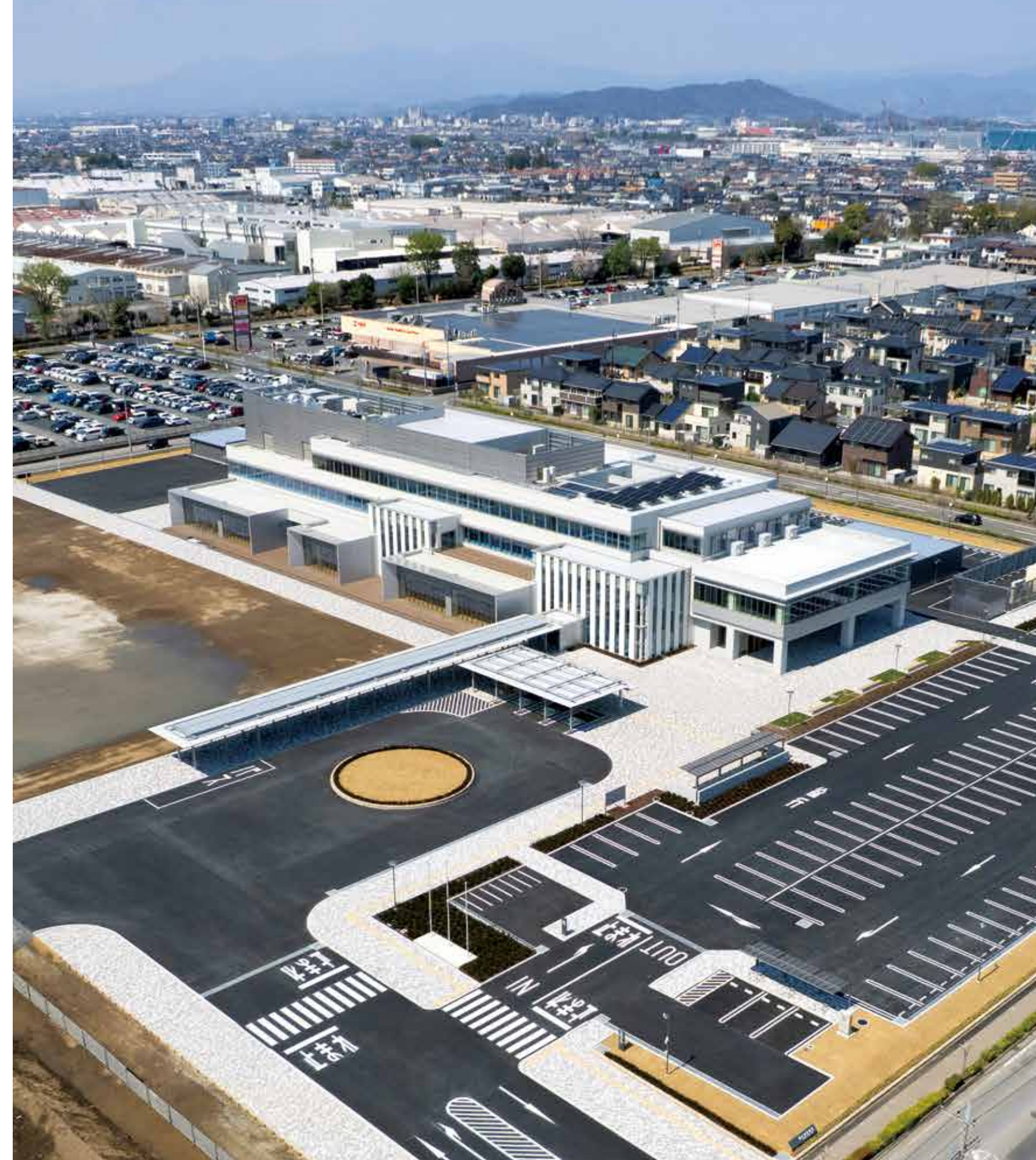
東南面空撮 庁舎の東・北には戸建て住宅、西側には工場が建ち並ぶ
