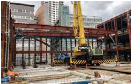
鉄骨建方状況
