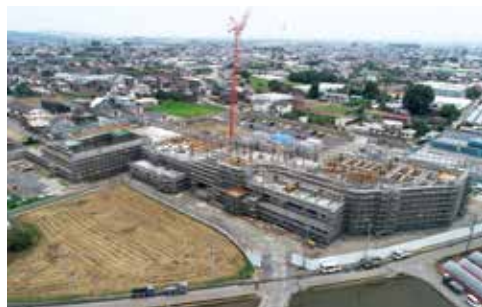
躯体工事中全景
