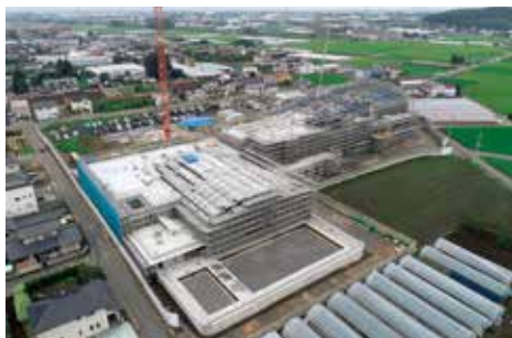
屋根鉄骨工事中全景
