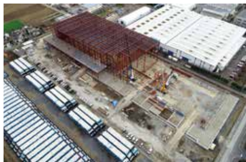
鉄骨建方状況
