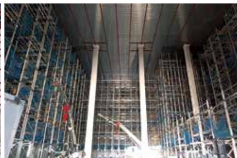
自動ラック式倉庫施工状況
