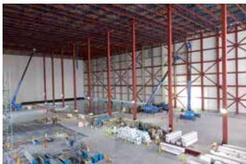
建屋内施工状況
